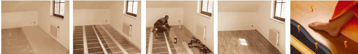
ECOFILM F608'in yüzer sistem parke zemin altına döşenmesiyle ilgili uygulama fotoğrafı
