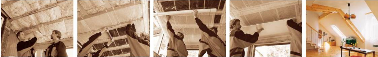
ECOFILM C ısıtma folyosunun metal kirişlere montajıyla ilgili uygulama fotoğrafları
