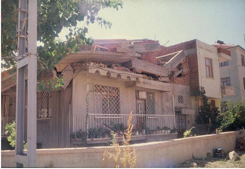
Şekil-1 Dinar’da 1995 Depreminde üst katları televizyon tuğladan yapılmış ve yıkılmış yapı
