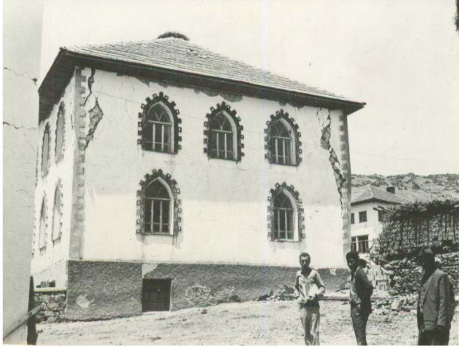
Şekil-4 Esnek kat döşemeli yığma yapıda deprem hasarı (1970 Gediz Depremi)
