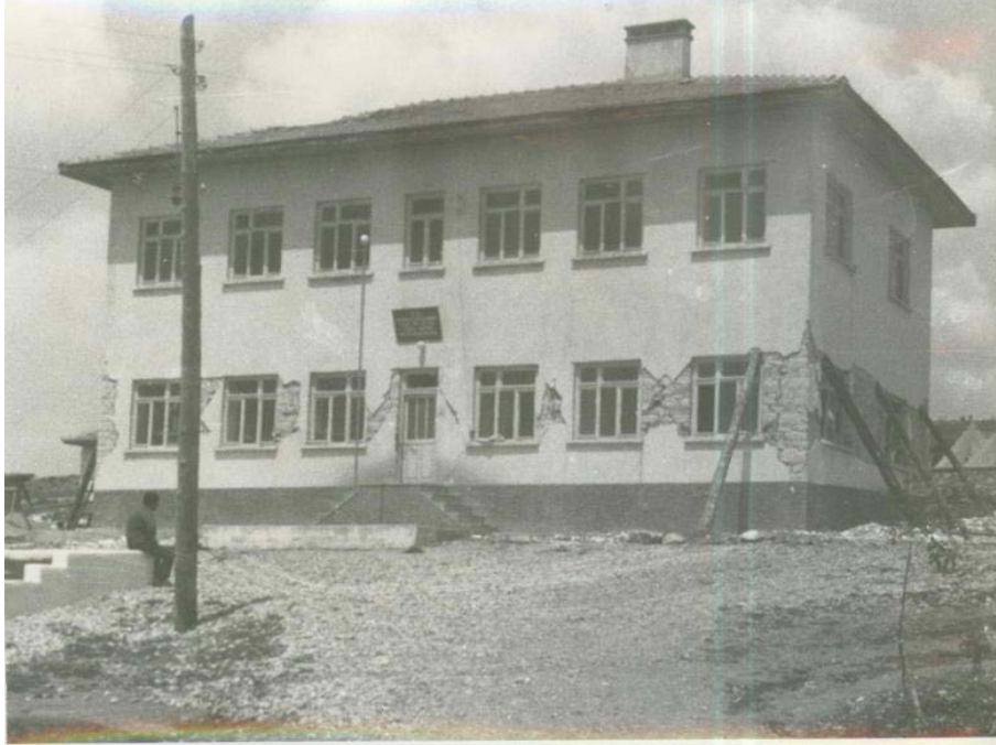
Şekil-3 Rijit Kat döşemeli yığma yapıda deprem hasarı (1970 Gediz Depremi)
