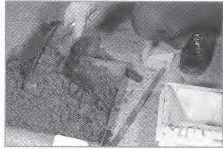
Betonun karıştırılması
