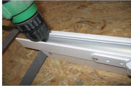
Resim 2.7: Yan kanal profilinin kısa tarafının dikme üzerine perçinlenmesi
