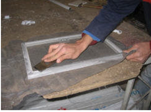
Resim 5.8: Sineklik teli fazlalıklarının kesilmesi
