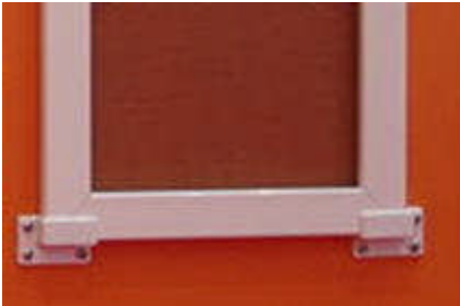
Resim 5.16: Sabit sinekliđin diđtan tutturulması
