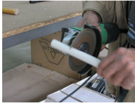
Resim 4.23: Yay borusunun kesilmesi
