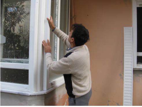
Resim 3.1: Panjur iskeletinin yerine kontrolünün yapılması
