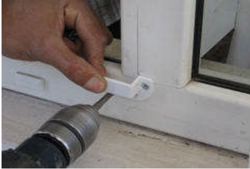
Resim 5.18: Tutturma aparatlarının pencere kasasına vidalanması
