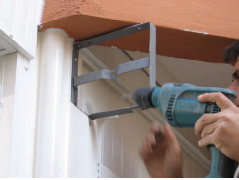
Resim 3.3: Başlık demirinin pencere kasasına vidalanması
