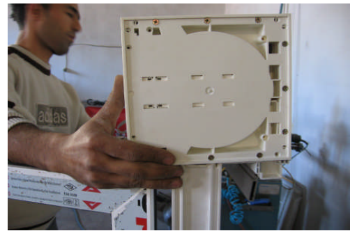
Resim 3.30: Panjur kutusunun pencere kasası üzerine konularak vidalanması
