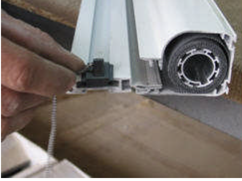
Resim 4.19: Bitim profiline tutamak ve fitilin takılması
