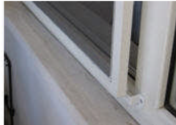
Resim 5.19: Sineklik çerçevesinin yerine takılması
