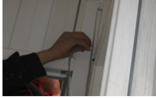
Resim 3.6: İpin içten geçirilerek ucunun kasnağa düğümlenmesi
