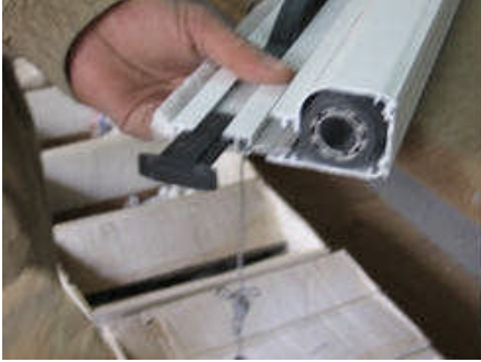
Resim 4.20: Bitim profili uçlarına stopların takılması
