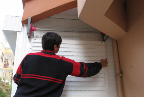
Resim 3.7: Panjur panosunun tambur borusu üzerine takılması
