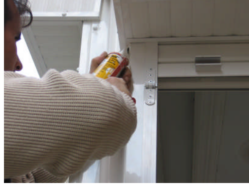
Resim 3.13: Kenarlara silikon veya çekomastik çekilmesi
