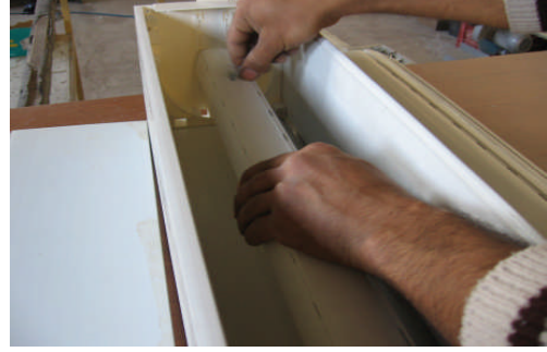
Resim 3.25: Panjur panosunun tambur borusuna vidalanması
