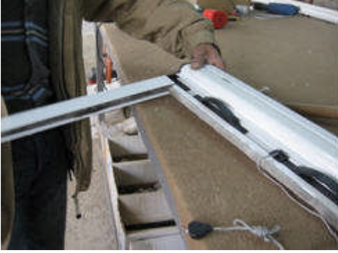
Resim 4.28: Yan kanal (u) profillerinin takılması
