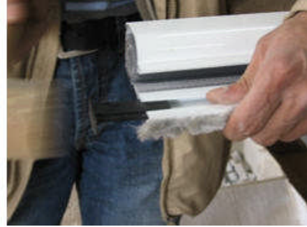
Resim 4.20: Bitim profili uçlarına stopların takılması
