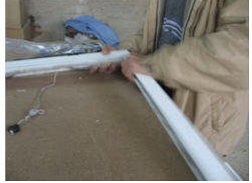
Resim 4.28: Yan kanal (u) profillerinin takılması
