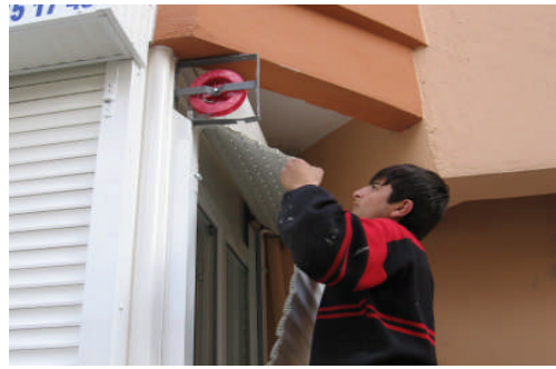
Resim 3.8: Panonun tambur borusu üzerine sarılması
