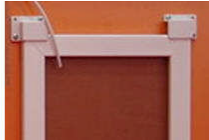
Resim 5.16: Sabit sinekliđin diđtan tutturulması
