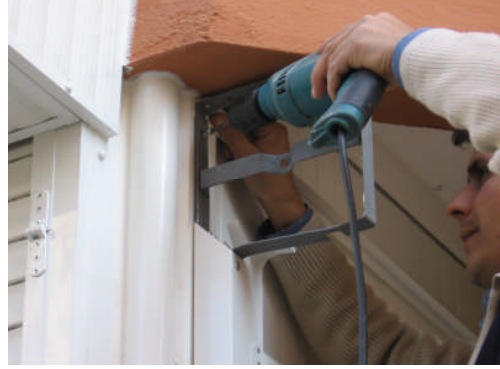
Resim 3.3: Başlık demirinin pencere kasasına vidalanması
