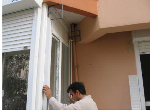
Resim 3.1: Panjur iskeletinin yerine kontrolünün yapılması
