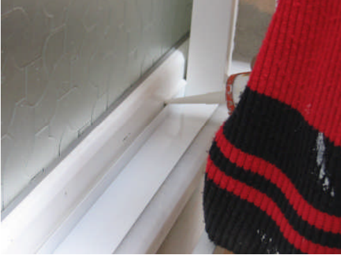
Resim 3.13: Kenarlara silikon veya çekomastik çekilmesi
