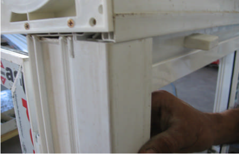
Resim 3.31: Yan kanal profillerinin pencere kasası üzerine konarak vidalanması
