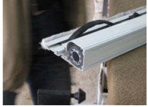
Resim 4.19: Bitim profiline tutamak ve fitilin takılması
