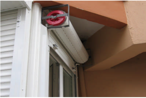
Resim 3.8: Panonun tambur borusu üzerine sarılması
