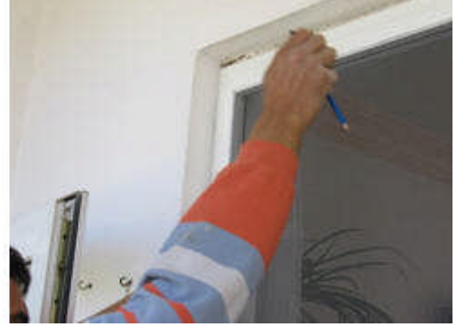
Resim 5.17: Sineklik çerçevesinin pencere kasasına markalanması
