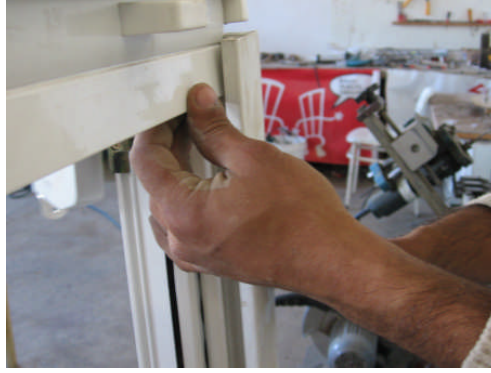
Resim 3.32: Diğer kanal profilinin pencere kasasına vidalanması
