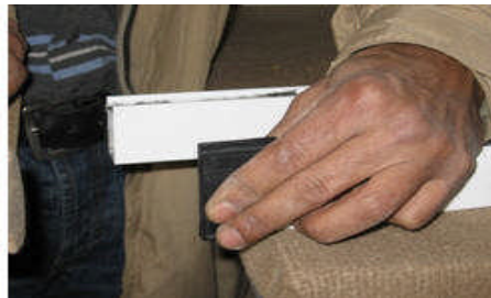
Resim 1.18: Stor alt stopları ve stopların takılması
