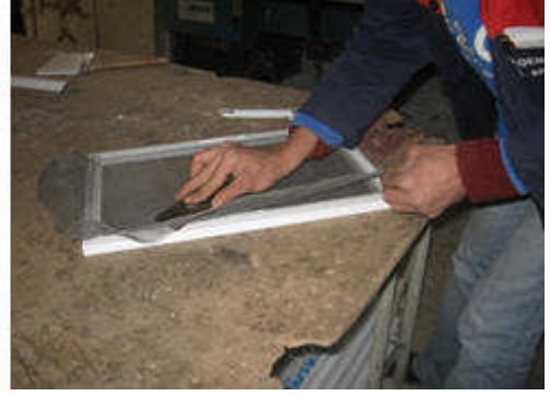
Resim 5.8: Sineklik teli fazlalıklarının kesilmesi
