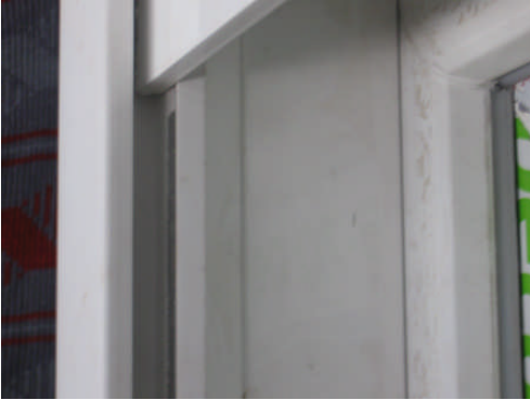
Resim 3.33: Panjur kanallarından önce sineklik kasasının konulması
