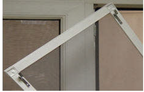
Resim 5.15: Sabit sineklik tutturma aparatları
