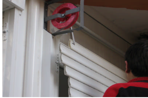
Resim 3.7: Panjur panosunun tambur borusu üzerine takılması
