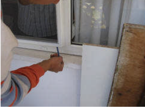
Resim 5.17: Sineklik çerçevesinin pencere kasasına markalanması
