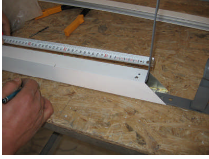
Resim 2.2: Yan kanal profil boyunun belirlenmesi
