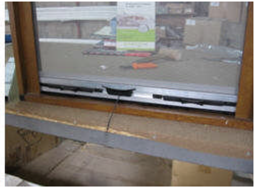
Resim 4.30: Dış çerçeve kasalı stor sineklik üst ve alt görünüşü
