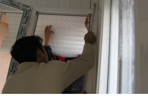
Resim 3.9: İç taraftan ipin çekilerek panonun sarılmasına yardımcı olunması
