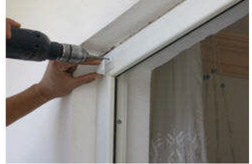
Resim 5.18: Tutturma aparatlarının pencere kasasına vidalanması
