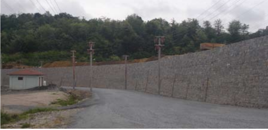
Zonguldak-Ereğli OSB yer seçim problemi (işletmeler tarafından toprak kaymasını önlemek için çok yüksek duvarlar yapmak zorunda kalmıştır.)
