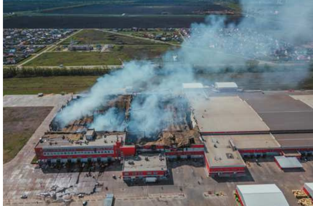
Görsel 7.5: Yangından zarar görmüş fabrika
